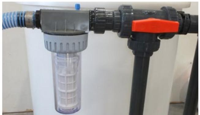
*Filtre à usage intensif et soupape à trois voies*
